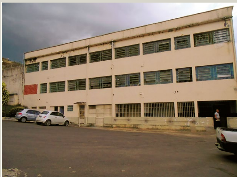
Figura 20 - Frente do bloco central da Penitenciária de Linhares. Fonte: Acervo Covemg
